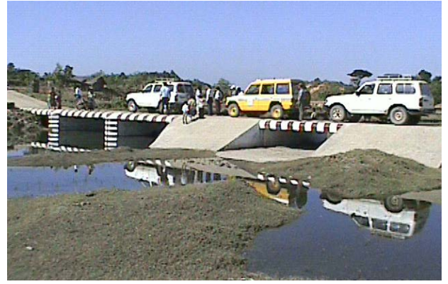
日本の技術を活かしてつくった沈下橋
