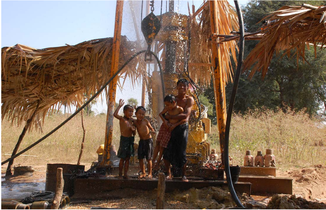
掘削した井戸にたまった泥水を出すあいだ、噴き出す水に集まる村人
