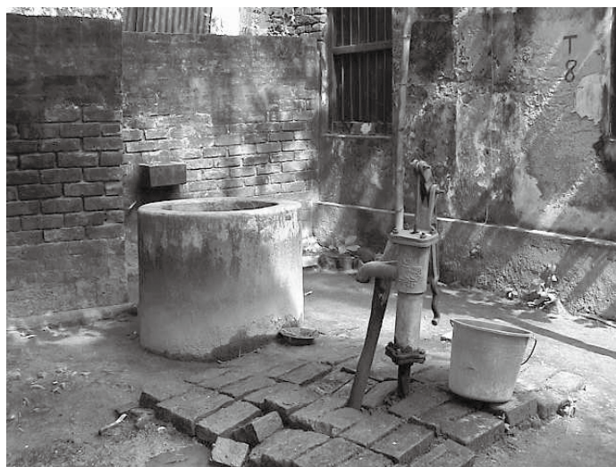
管井戸(右)が脇に掘られ、使われなくなった掘り抜き井戸(左) (バングラデシュ南西部)
