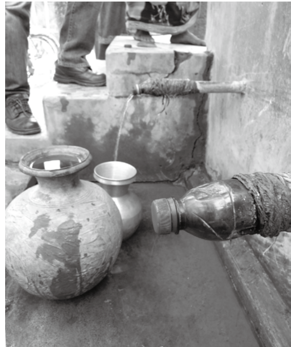
代替水源の蛇口はみんなが使うためよく壊れる。ローカルエンジニアのアイデアでペットボトルの蓋を採用。ローコスト（無料？）でメンテナンス。
