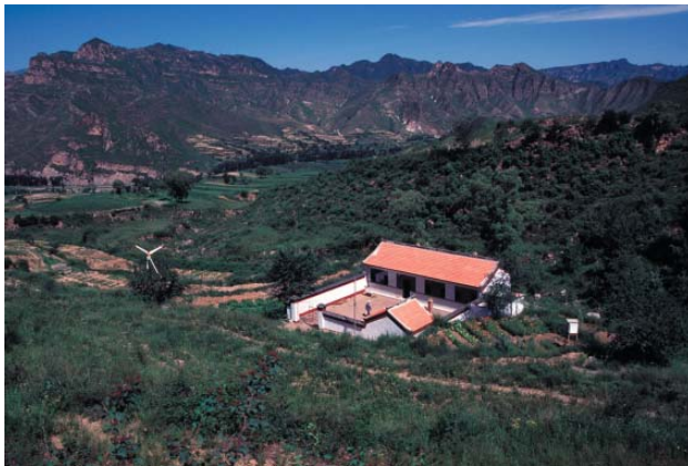
管理棟（2000年）。周辺の植物はまだ小さい
