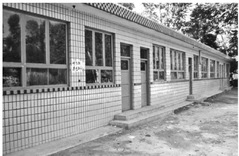
労賃をプールし、ほかからも寄付を集めて校舎を建て替えた（1994年）
