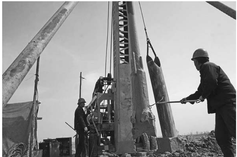
井戸を掘る。深さ 140m で 1 時間 40m 3 の水が確保された
