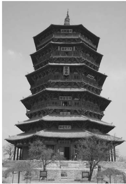
応県の木塔。鉄釘を使わず、木組みだけで建造されている
