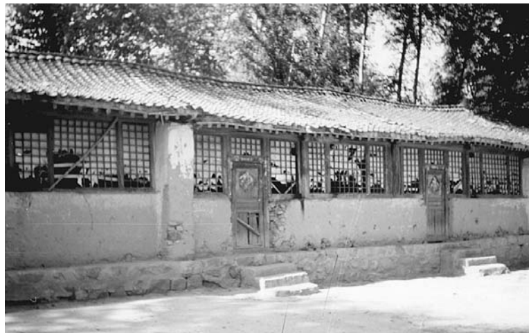
下寨北小学校の旧校舎。零下30℃になるのに窓は障子張り（1993年）
