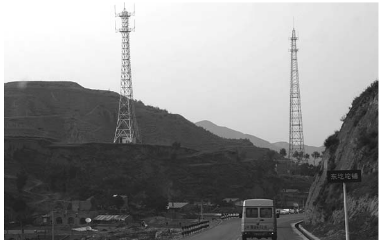
通信網が急速に整備された。アンテナが2本セットで立つ
