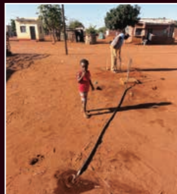
再定住先に初めてひかれた水道
