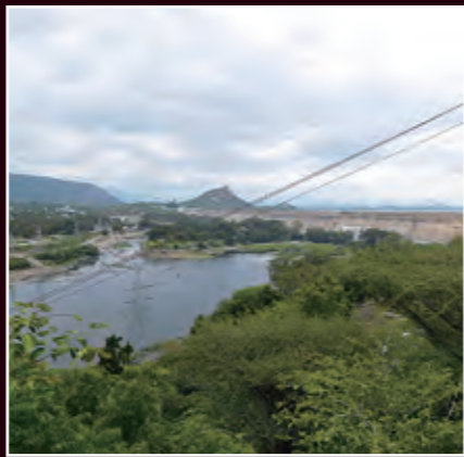
カーヴェリー川を堰き止めるタミルナードゥ州 Mettur ダム。上流のカルナータカ州での取水による水量減が問題化している(2016年7月)
