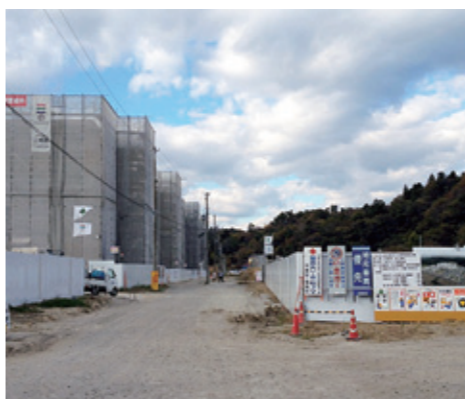
道を挟んで左側に原子力被災者向けの下神白団地、右側に津波被災者向けの小名浜団地が建築されている
