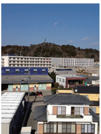
建築中の下神白団地・小名浜団地
