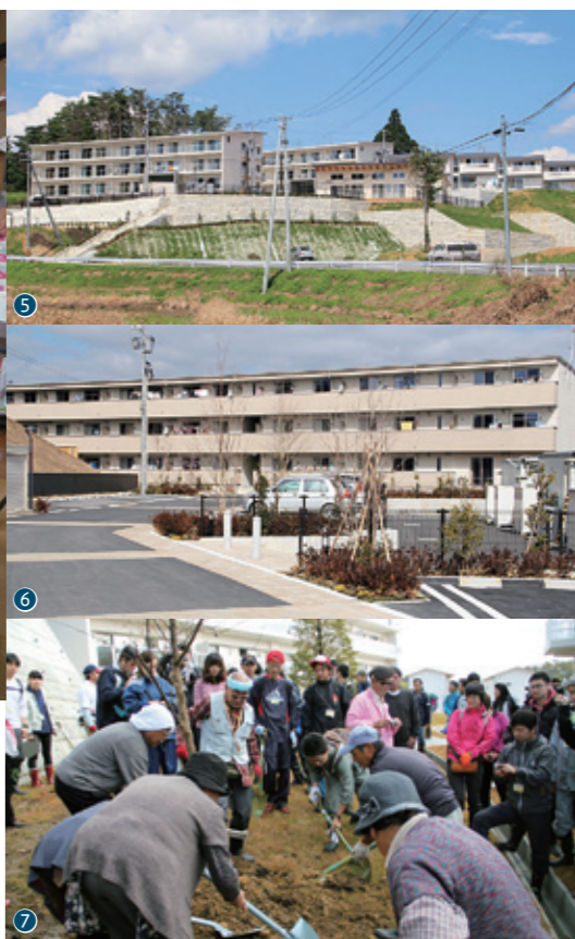
⑤2014年8月に入居が始まった町内最初の「災害公営住宅」(33戸)。⑥2015年2月に入居が始まった町内3団地目となる「町営枳沢復興住宅」(集合タイプ20戸)。⑦災害公営住宅入居者と支援団体による桜の記念植樹。⑧町が主催する災害公営住宅入居予定者対象の「くらしの懇談会」ではファシリテーター役も務めました。⑨「復興みなさん会」定例会の様子
