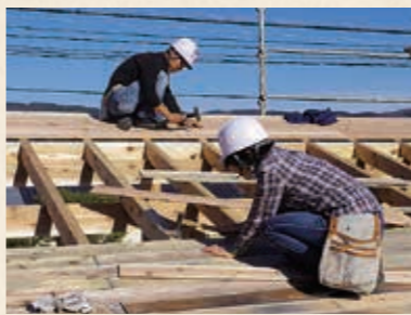
屋根の野地板張りも手伝いました
